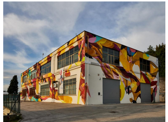
Giorgio Bartocci_Self Protection, Architettura liquida nr.10_PopUpFestival2020, Osimo_capannone industriale SS 16 km 309.5_ph Aurelio Laloni
