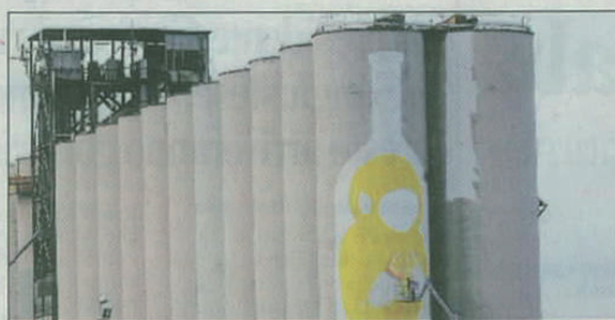
I silos del porto prendono colore (FOTO PEROZZI)
