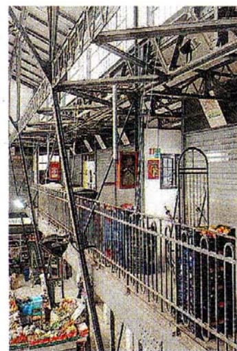
SI CAMBIA Interventi sul primo piano della struttura
